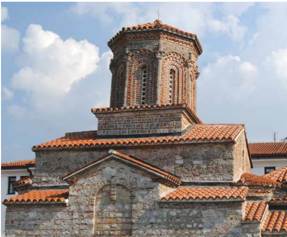
ГЛАВНАТА КУПОЛА И ПОКРИВНАТА КОНСТРУКЦИЈА
